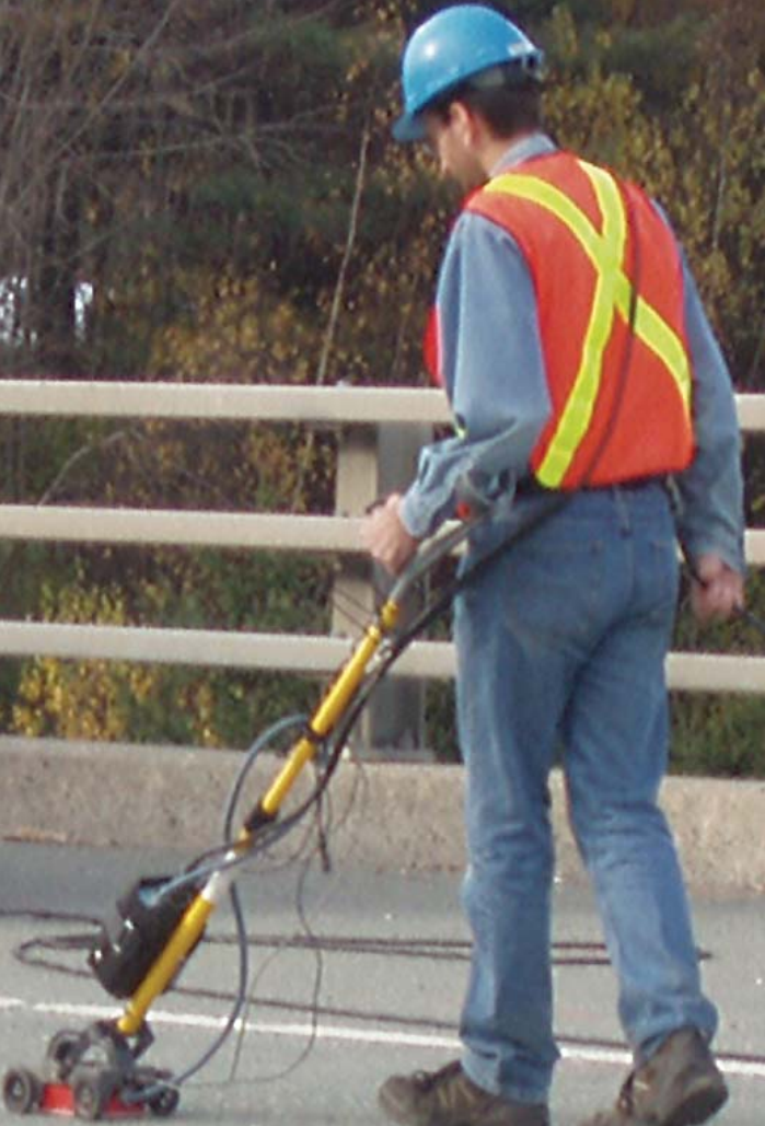
Relevé géoradar sur une dalle de tablier de pont
