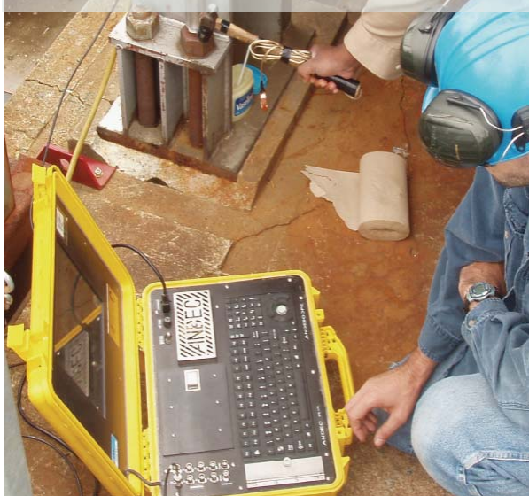
Évaluation de l'état des ancrages par ultrasons
